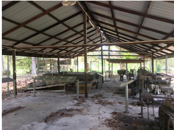
Sebelum kerja-kerja pembersihan.
